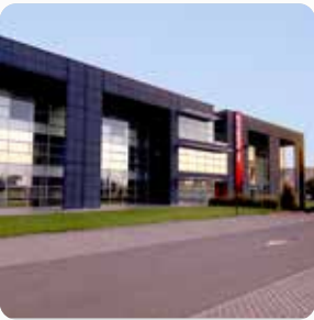
Galtech Site Cavriago (RE) • Italy
